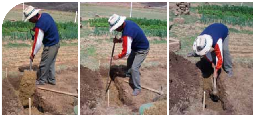
Abonado y aflojado de los 60 cm de suelo
