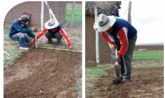
Marcando el terreno con ayuda de un flexómetro, estacas y una picota
