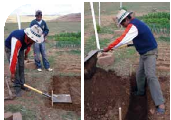
Excavación del terreno según la técnica
