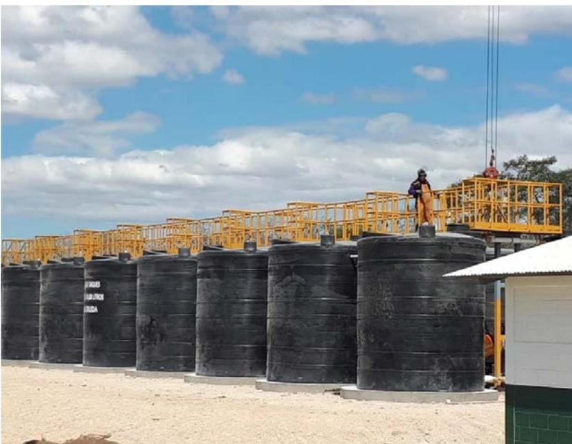
Sistema de bombeo Boosterpaq y almacenamiento de agua para granjas de la industria avícola, ubicada en el municipio Larreynaga-León, con esta obra se garantizó el suministro continuo de agua para la producción y el procesamiento del rubro. Se utilizaron equipos de bombeo con variadores de frecuencia para reducir el consumo energético de la planta. Cada finca tiene una capacidad de almacenamiento de 374,000Lts y con capacidad de manejar 239gpm.
