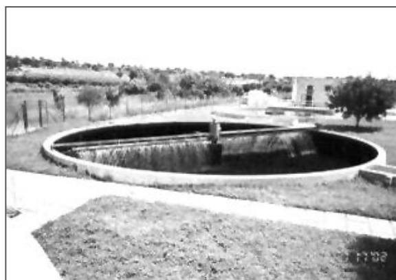
FIGURA . MODELO DE FILTRO PERCOLADOR EN ZONA AGRÍCOLA
