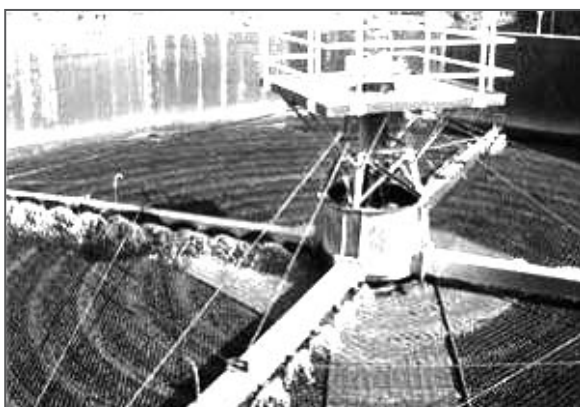
FIGURA . MODELO DE FILTRO PERCOLADOR EN ZONA URBANA
